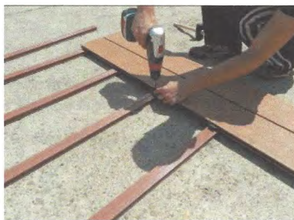
Fig. 5. Fixarea clemelor de prindere la al doilea profil
