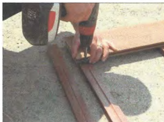
Fig. 3. Fixarea clemei de prindere la 3 cm de capatul profilului tip WPC
