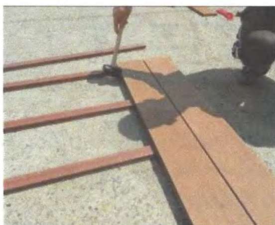
Fig. 4. Glisarea profilului tip WPC sub clemele deja fixate ale primului profil
