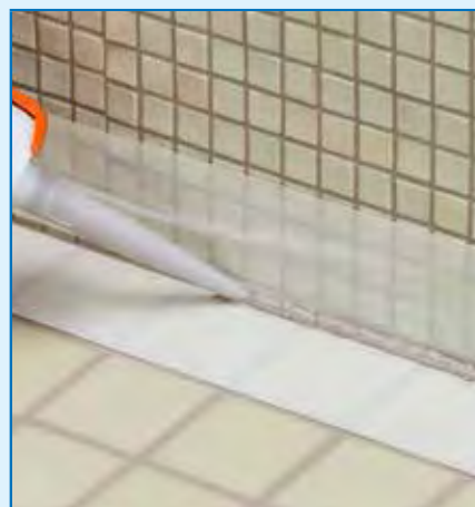
Realizarea rosturilor elastice dintre pereti si pardoseala cu etansant elastic
