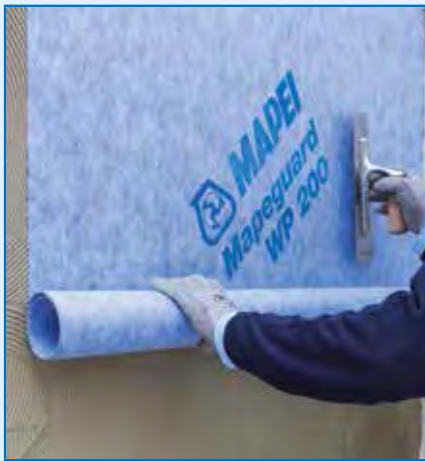
Aplicarea primei fasii de membrana MAPEGUARD WP 200
