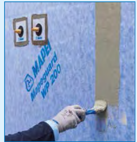
Aplicarea MAPEGUARD WP ADHESIVE pe imbinarea dintre fasiile de membrane pentru lipirea si sigilare imbinarii cu MAPEGUARD ST
