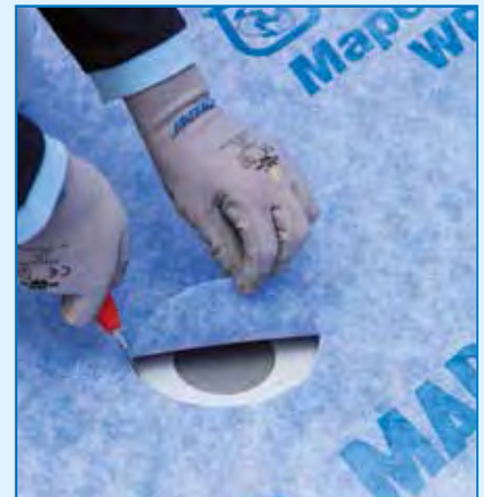
Decuparea membranei in dreptul gurii sifonului de pardoseala
