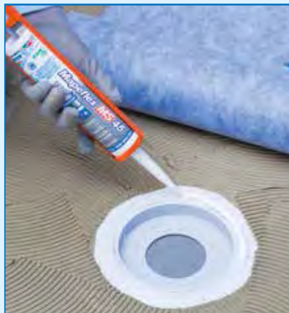
Detaliu sigilare sifon; imbinarea se sigileaza suplimentar cu etansantul MAPEFLEX MS 45
