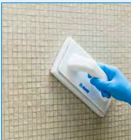
Curatarea si finisarea rosturilor la o placare cu mozaic cu padul abraziv tip Scotch Brite umed
