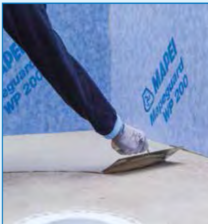
Aplicarea adezivului pe baza de ciment C2, pentru lipirea membranei
