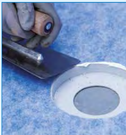
Presarea si lipirea membranei MAPEGUARD WP 200 pe sifonul de pardoseala
