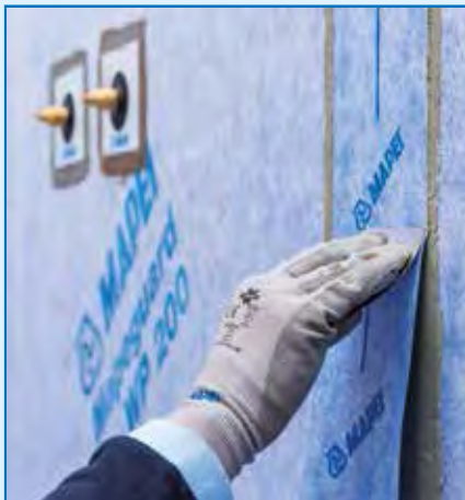
Aplicarea benzii MAPEGUARD ST
