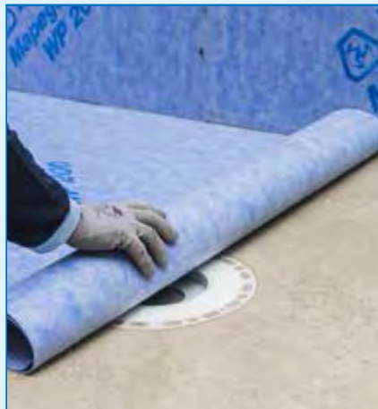
Pozitionarea membranei in camp si peste gura de sifon de pardoseala in vederea decuparii gurii de scurgere
