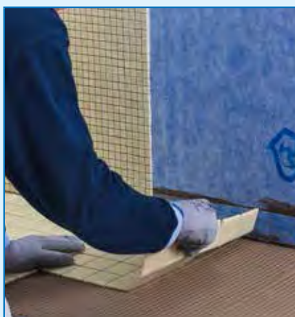
Realizarea placarilor la pardoseala cu adeziv pe baza de ciment C2
