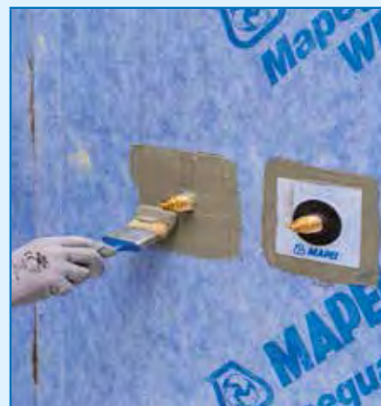
Aplicarea piesei de etansare strapungeri MAPEGUARD PC cu MAPEGUARD WP ADHESIVE
