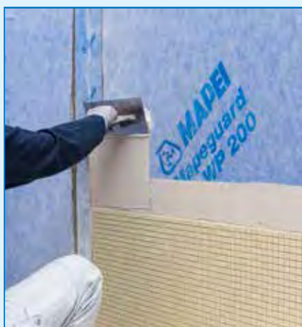
Realizarea placarilor la pereti cu adeziv pe baza de ciment C2
