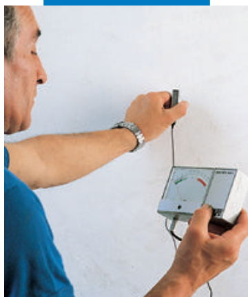
Verificarea umidității din tencuiala pe bază de ipsos
