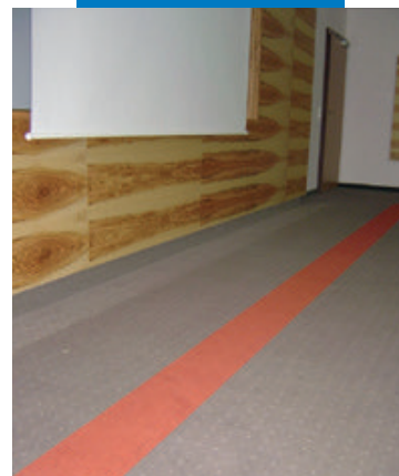
Exemplu de utilizare a amorsei Primer G înainte de turnarea șapei autonivelante Ultraplan Eco și aplicarea adezivului Rollcoll pentru lipirea mochetei într-o cameră de hotel - Villa Hotel Castellani - Austria
