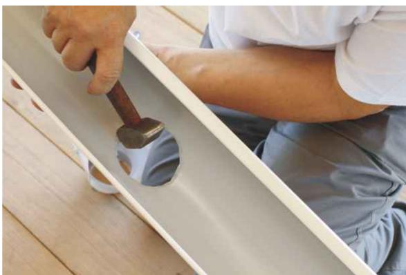
fig. 5989 - Marginea decupată se îndoiește în jos cca. 3 mm pentru a împiedica apa să se preleagă pe partea inferioară a jgheabului.
