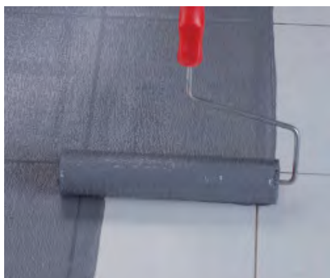
Aplicarea Eco Prim Grip Plus cu un trafalet pe placi portelane existente
