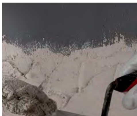
Aplicarea de tencuiala pe Eco Prim Grip Plus
