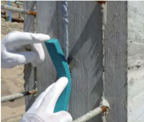
Aplicarea Idrostop Soft pe suprafete verticale
