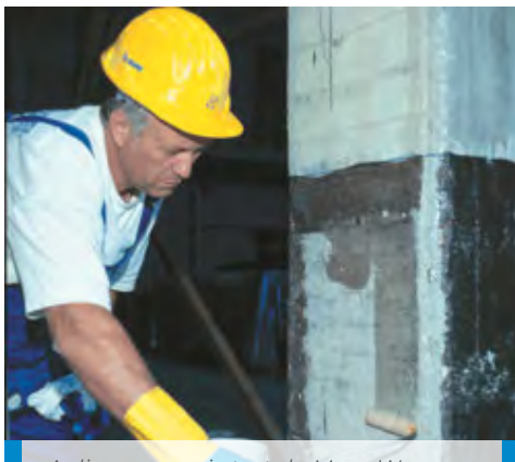
Aplicarea unui strat de MapeWrap Primer 1
