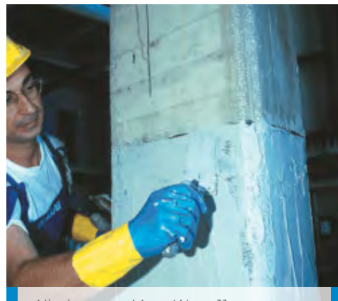
Nivelarea cu MapeWrap 11 sau MapeWrap 12
