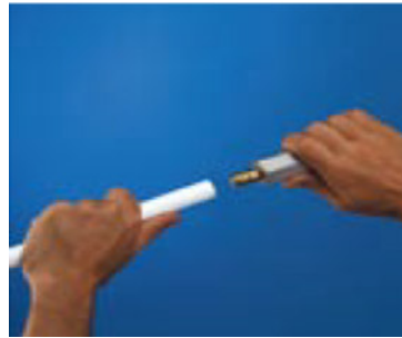
5. Piulitele fittingului se strâng cu cheia.
