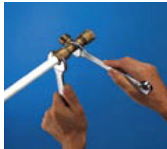
5. Piulitele fittingului se strâng cu cheia.
