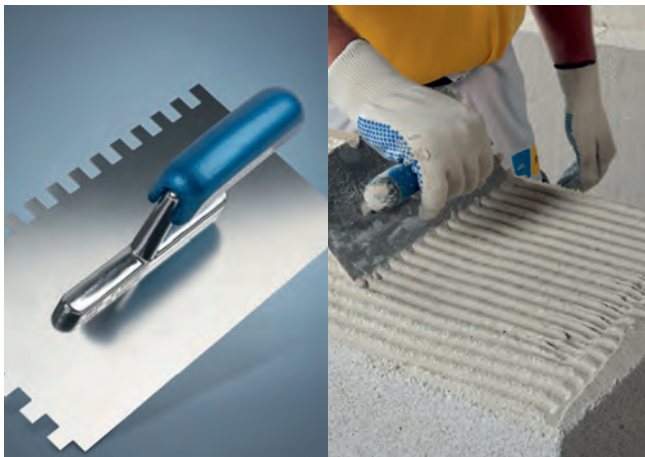
Drișcă metalică cu dinți (10 mm profilație pentru plăci \leq 150 mm; 12 mm profilație pentru plăci > 150 mm)
