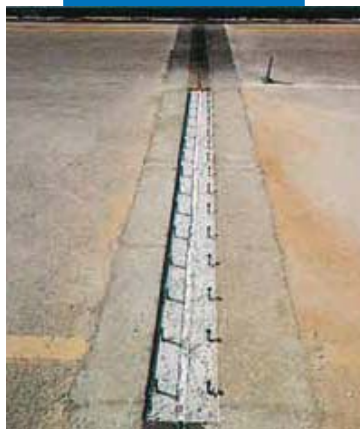
Repararea rosturilor rigide la un pod de autostrada cu Maefill
