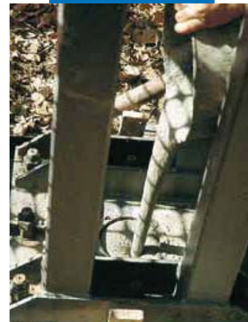
Ancorare confectione metalica cu Mapefill
