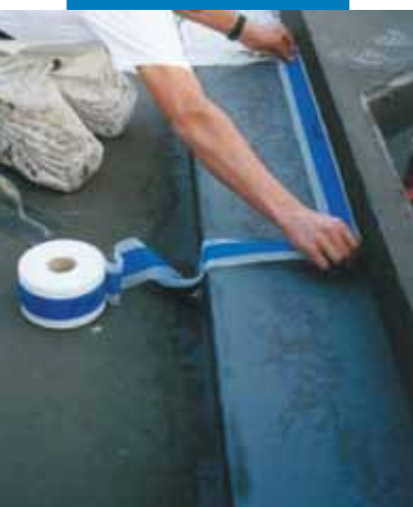
Un exemplu de impermeabilizare elastică cu Mapeband a unui unghi situat între radier și perete
