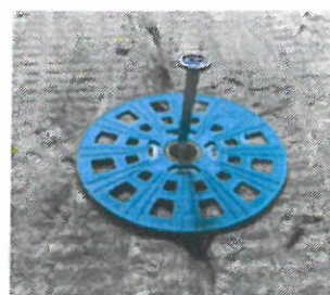
Presare flanșă pe placă și introducerea tijă
