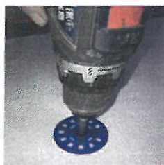
Înfiletare/presare completă a tijei
