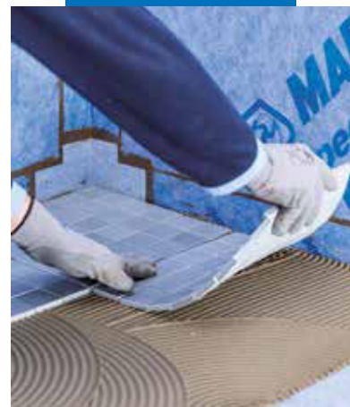
Montarea placilor ceramice
