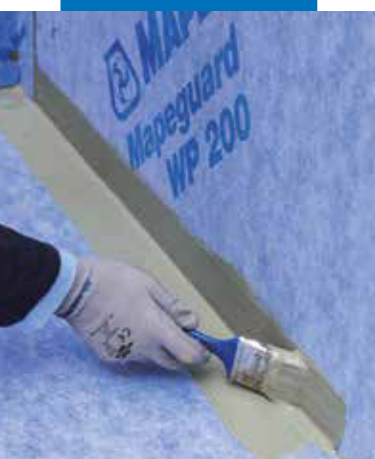
Aplicarea Mapeguard WP Adhesive pentru a sigila rosturile de colt inaintea aplicarii Mapeguard ST
