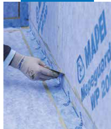
Aplicarea Mapeguard ST
